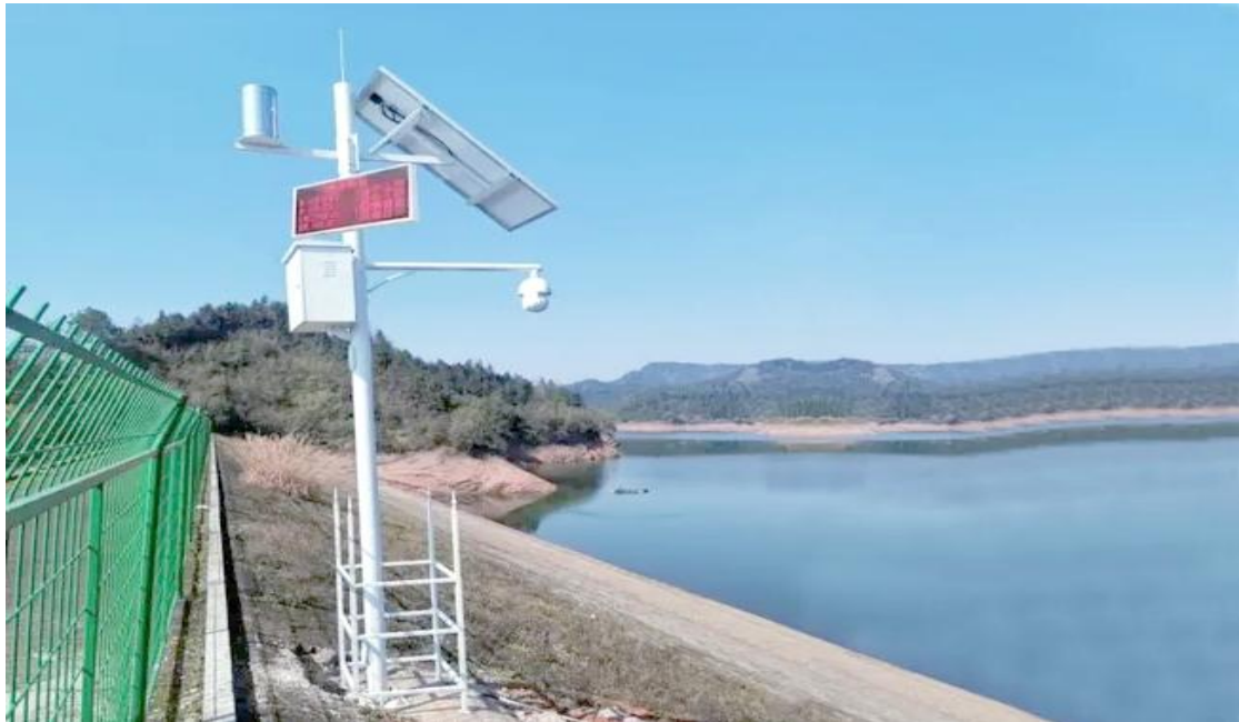
图 1：水库智能检测设备
