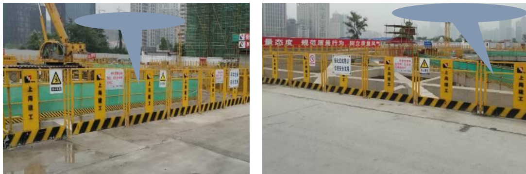
图 2 定型化基坑支护
