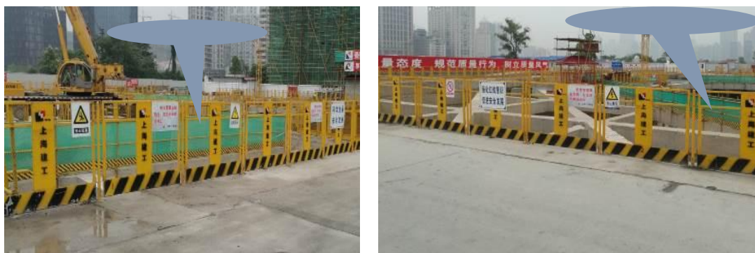
图 2 定型化基坑支护
